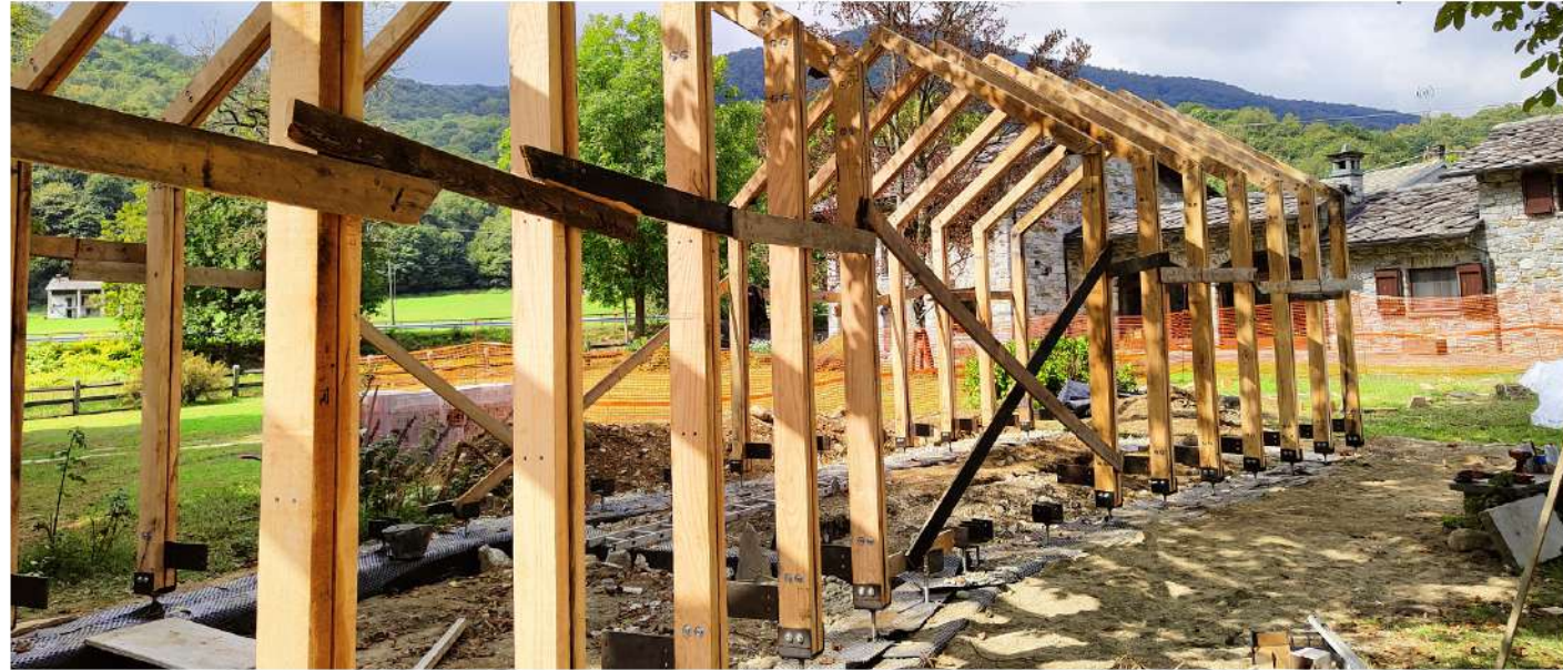
Foto 1 | Posa in opera dei portali
